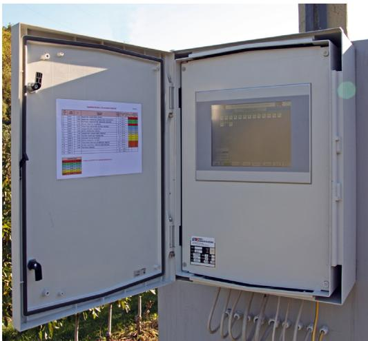
Abb.3: „IrriTouch“ Steuerung montiert in einem Wandgehäuse
