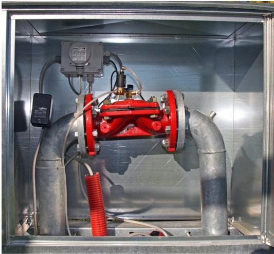
Abb.1: Ventilkasten mit montierter Feldeinheit und Rückmeldung (Pressostat)
