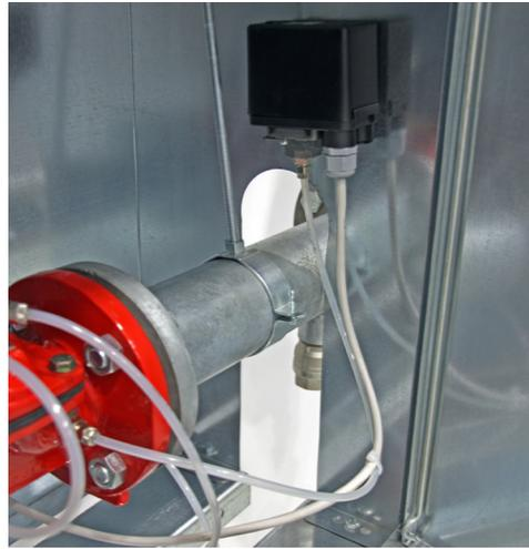
Abb.2: montierte Rückmeldung (Pressostat)
